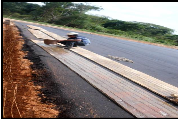
Figura 22. Encofrado del canal. Fuente: Gerencia de construcción, PDVSA
