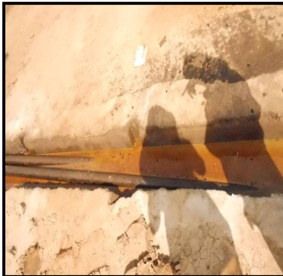
Figura 15. Canal Lleno de aguas aceitosas y en mal estado. Fuente: Autor
