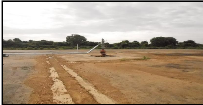
Figura 16. Instalación de Línea de flujo Fuente: Autor
