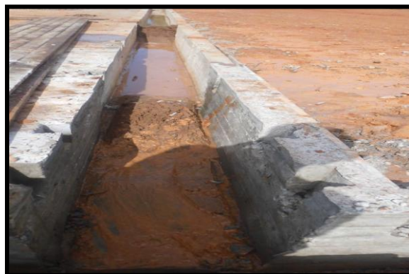
Figura 24. Desencofrado y curado de las paredes del canal. Fuente: Gerencia de construcción, PDVSA
