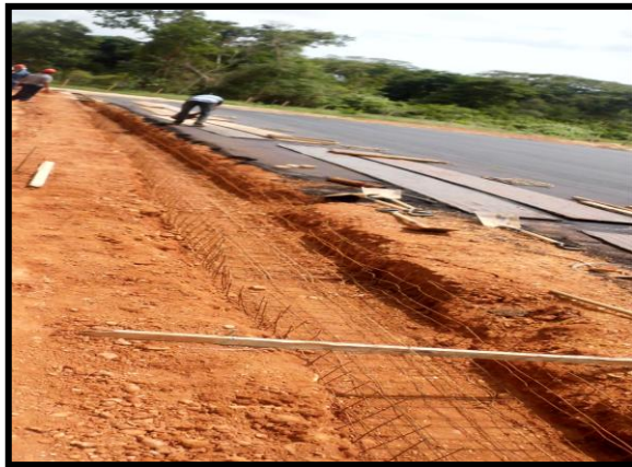
Figura 20. Excavación y colocación del acero de refuerzo. Fuente: Gerencia de construcción, PDVSA
