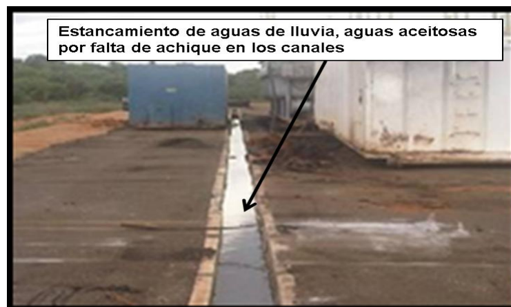
Figura 8. Problemas y fallas presentes en la LOC JK-Y Fuente: GPDVSA (2011)
