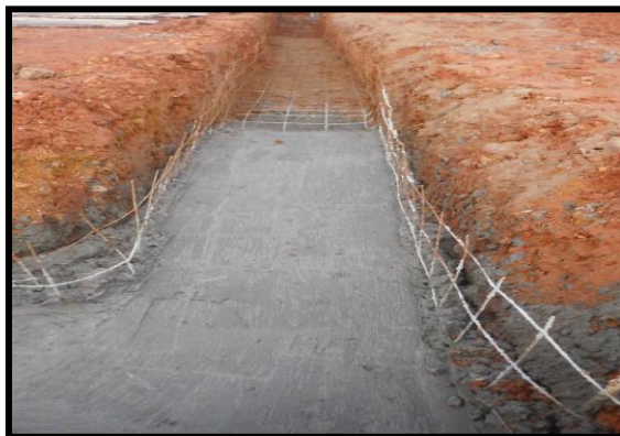
Figura 21. Vaciado de concreto en el piso del Canal Fuente: Gerencia de construcción, PDVSA
