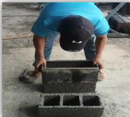
Figura 11. Desmoldado de los bloques Fuente: Autores
