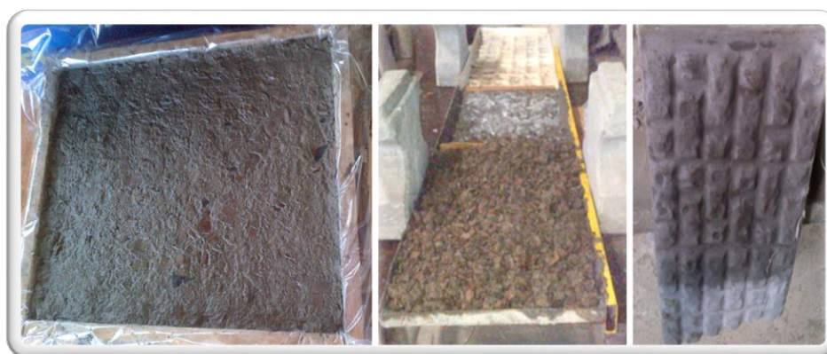
Figura 12. Vaciado de mezcla en encofrados
