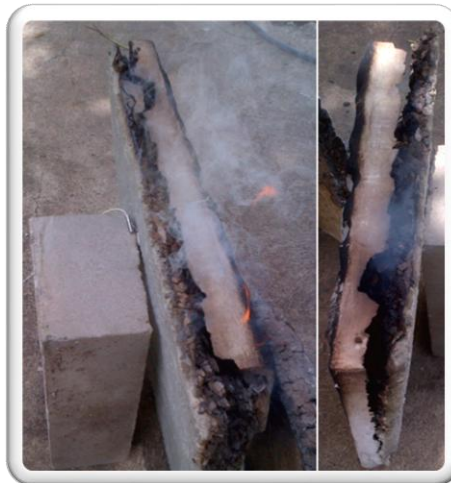
Figura 19. Desprendimiento del Friso
