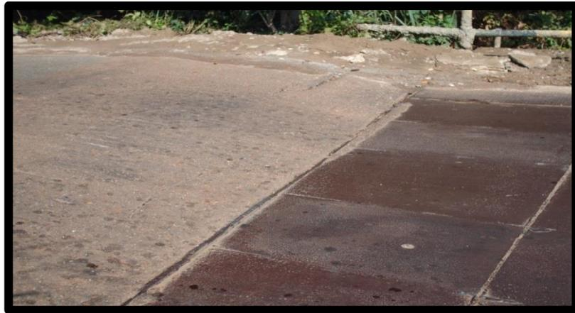
**Figura 12. Fractura transversal presente en el pavimento que da acceso al puente principal.
