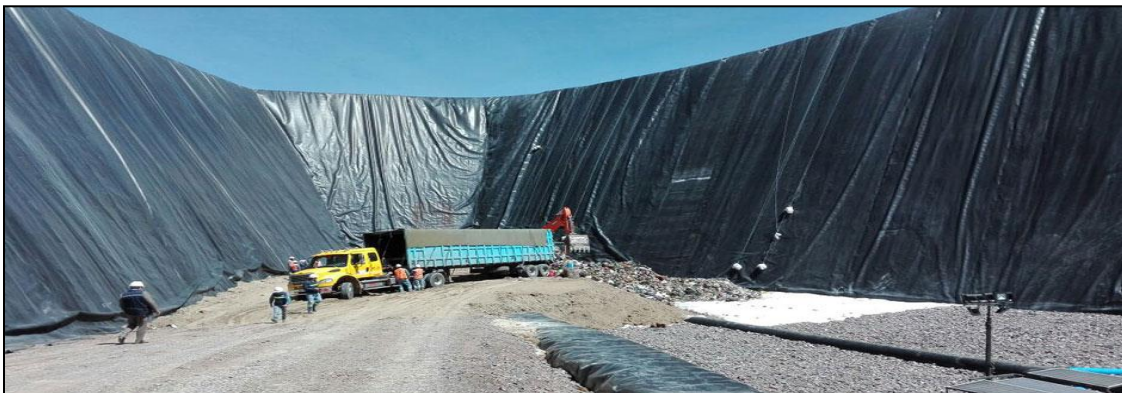
Figura 2.9 Construcción de relleno sanitario tipo trinchera.
