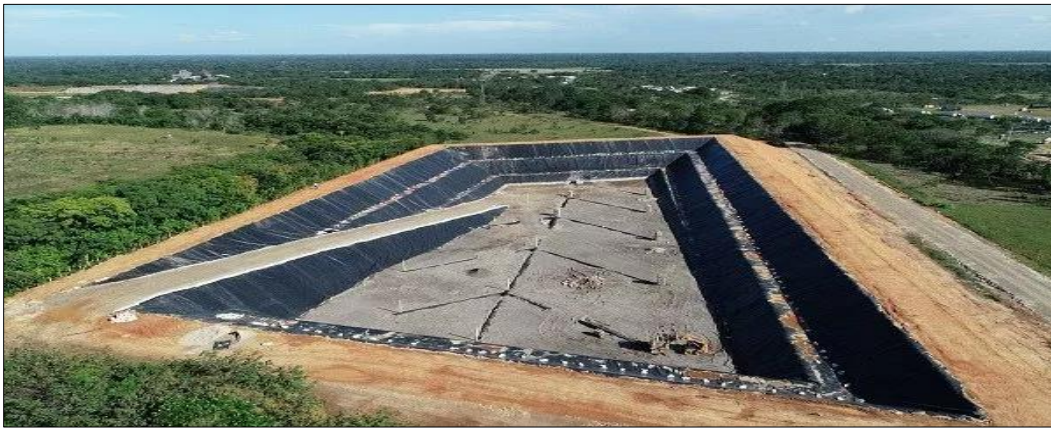
Figura 2.7 Relleno sanitario tipo área.
