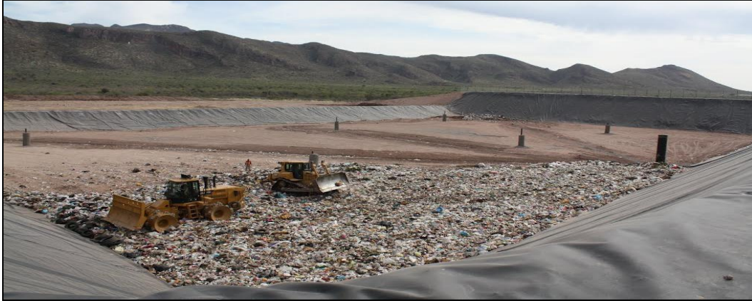
Figura 2.8 Relleno sanitario tipo rampa.
