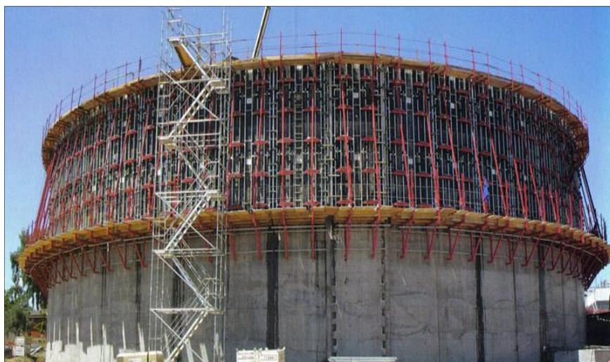
Figura 24. Sistema de encofrado para muros curvos con grúa.
