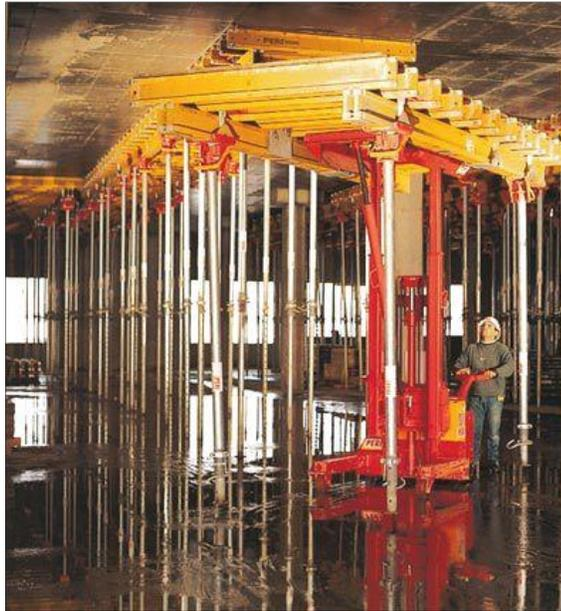
Figura 43. Carro elevador de encofrado de mesas.
