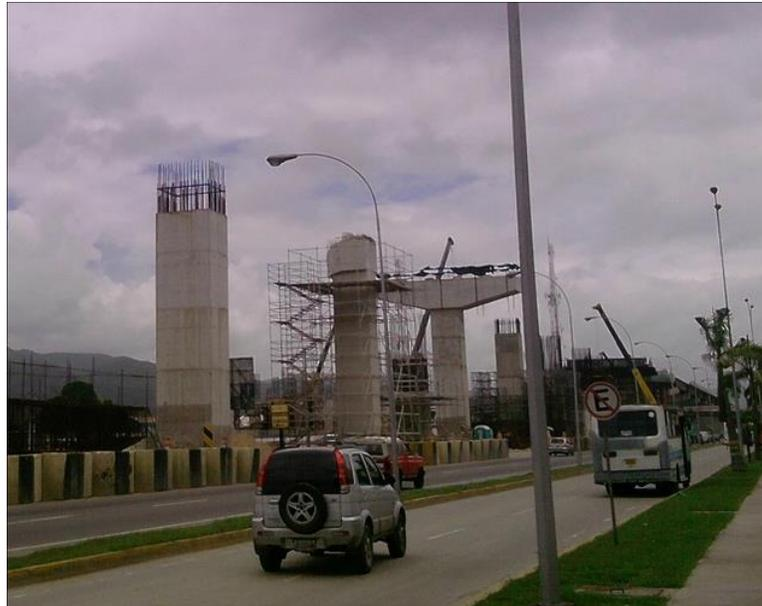
Figura 54. Pilotes Viaducto Guarenas-Guatire.
