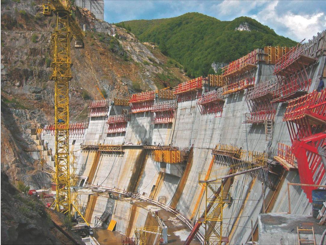
Figura 32. Sistema de encofrados trepante a una cara sobre presas.
