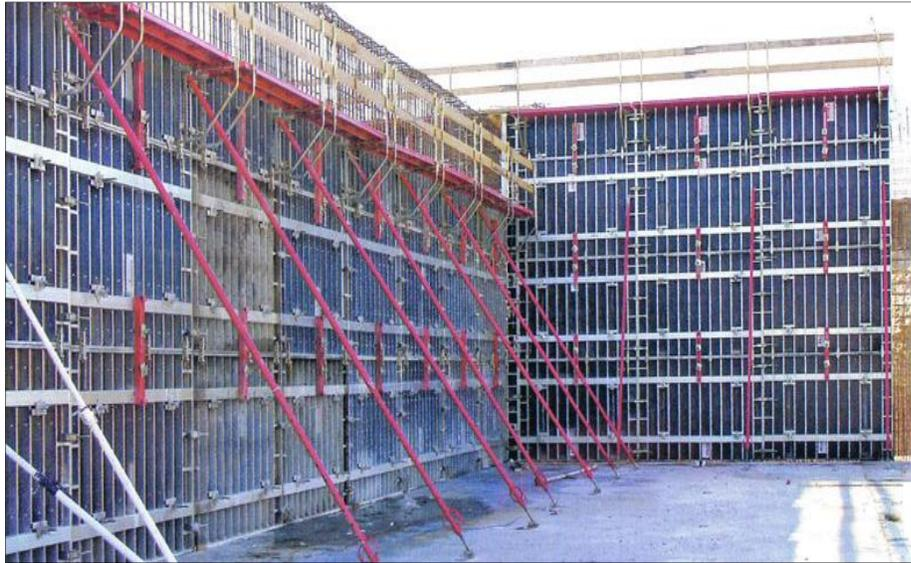
Figura 23. Sistema de encofrado para muros rectos con grúa.
