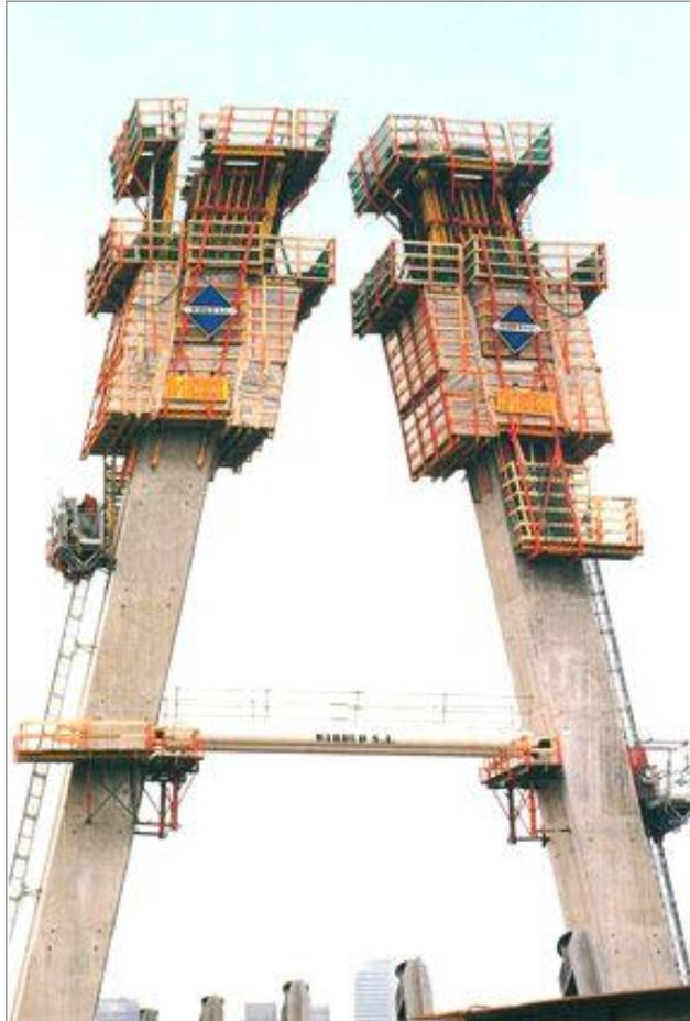
Figura 40. Sistema de encofrado autotrepante variable.
