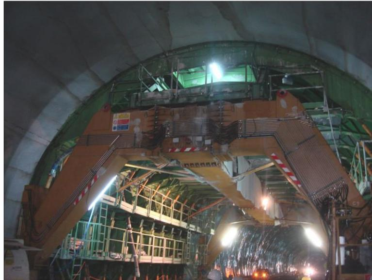
Figura 47. Sistema de encofrado especial.
