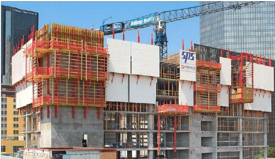
Figura 30. Sistemas de encofrados de una cara.
