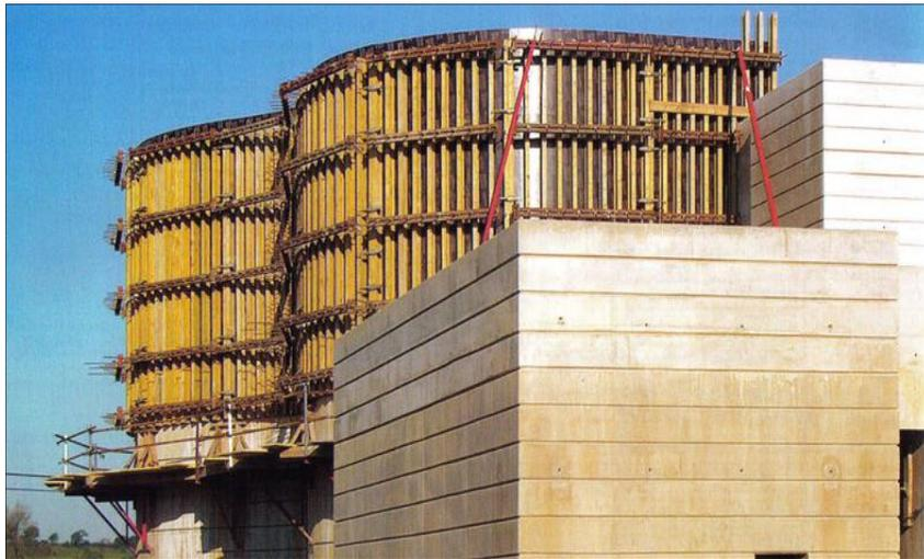
Figura 25. Encofrado para muros mixtos con grúa.
