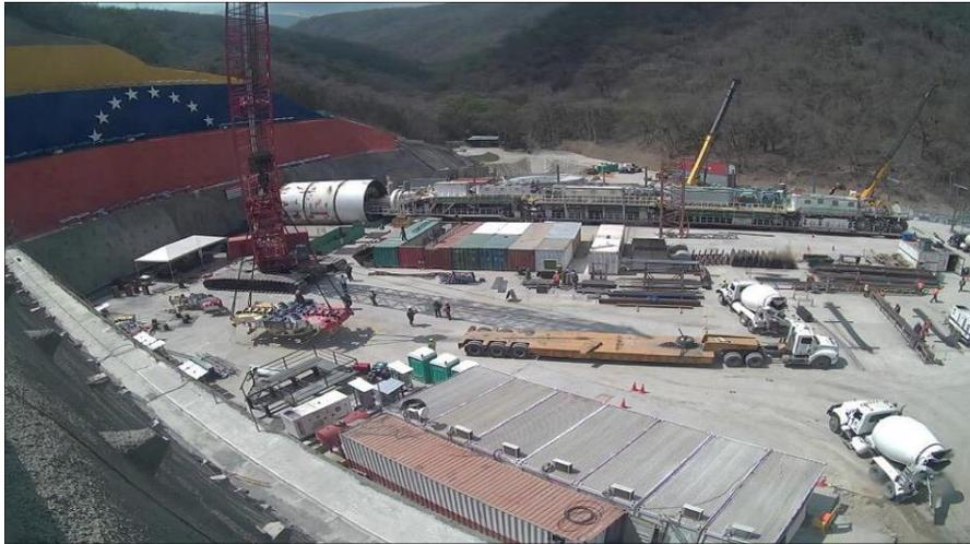
Figura 51. Sistema de excavación túnel minero TBM.
