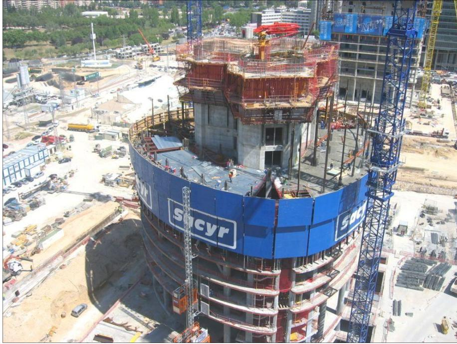
Figura 37. Sistema de encofrado autotrepante con plataforma.
