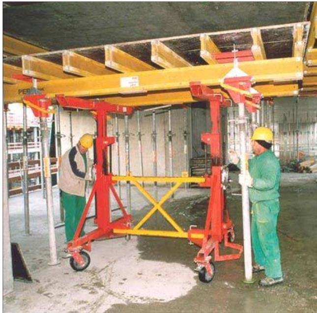
Figura 42. Sistema de encofrado horizontal – encofrado de mesas
