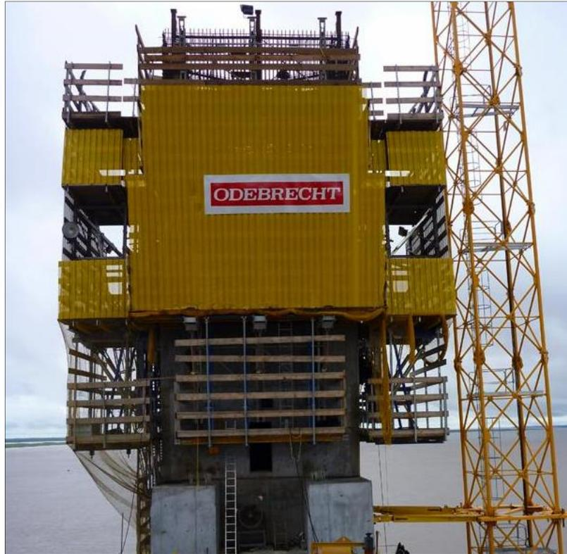
Figura 50. Sistema autotrepante SKe 100 DOKA.
