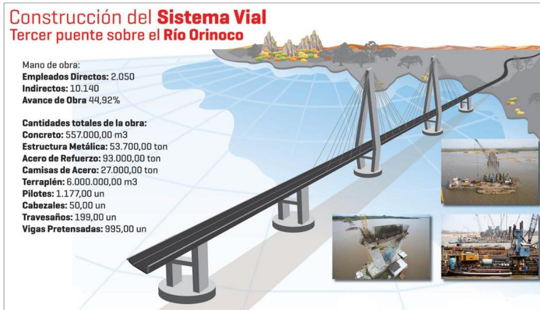
Figura 3. Características Tercer puente sobre el Río Orinoco.
