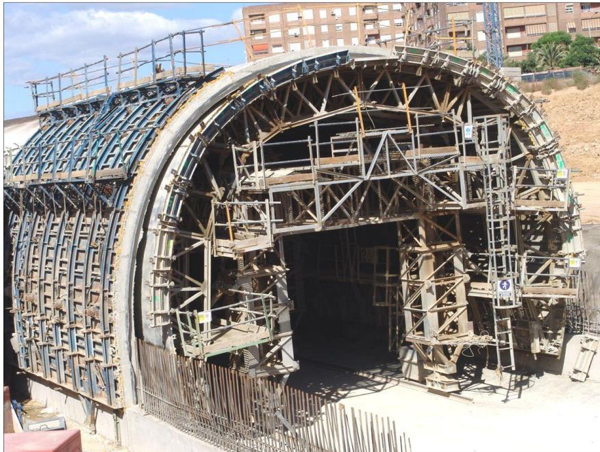
Figura 46. Encofrado especial tipo túnel.
