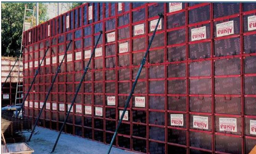
Figura 22. Sistema de encofrado de muros manuales.
