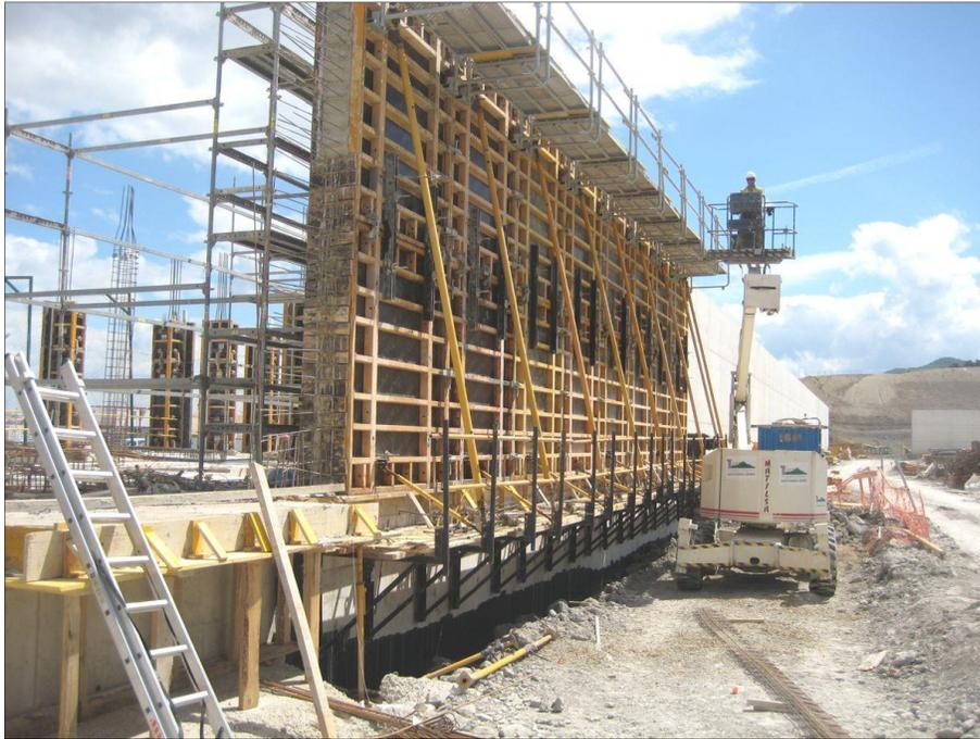
Figura 19. Encofrado para muros.
