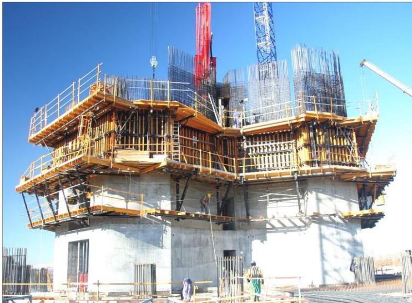
Figura 36. Sistema de encofrado autotrepante estándar.
