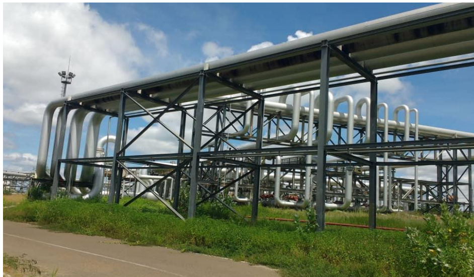
Figura 4.1. Puente de tubería PR-02 existente, parte 1, pórticos J- I- H- G Fuente: Autor (2020)
