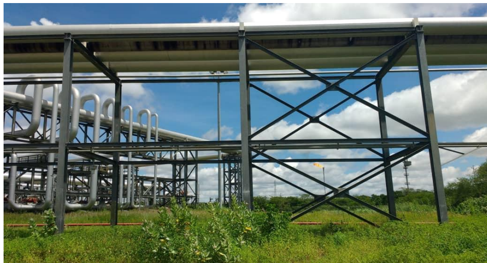
Figura 4.2. Puente de tubería PR-02 existente, parte 2, pórticos G- F- H Fuente: Autor (2020)
