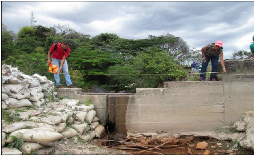
Figura 5.1 Trabajo topográfico en el dique Wará II
