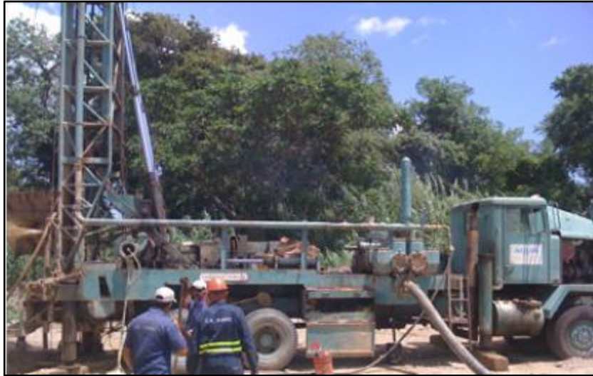
Figura 3.10 Camión de perforación (C.A. Parko, 2024).
