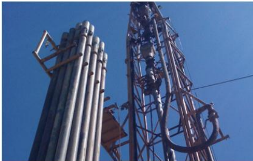
Figura 3.7 Cabria con tubería de perforación (C.A. Parko, 2024).
