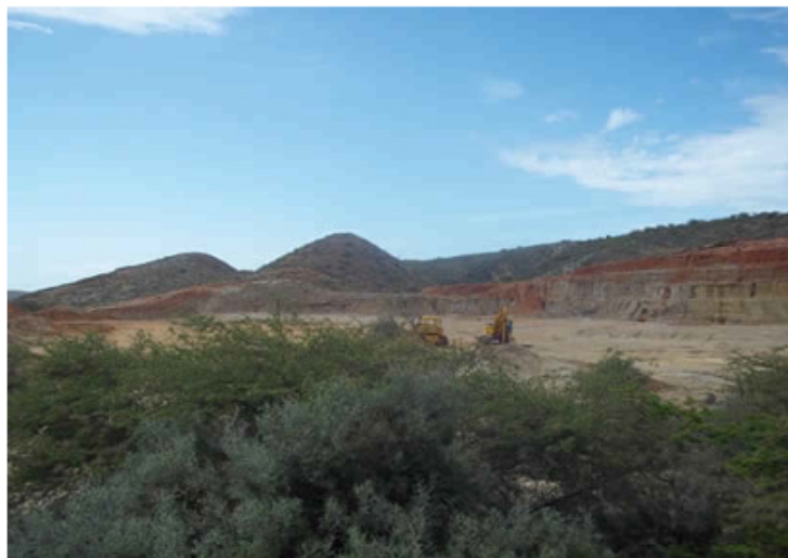
Estas maquinarias están destruyendo la vegetación aledaña a la Laguna Madre, con una clara y falta de visión y escrúpulos del gobierno. Foto del autor.
