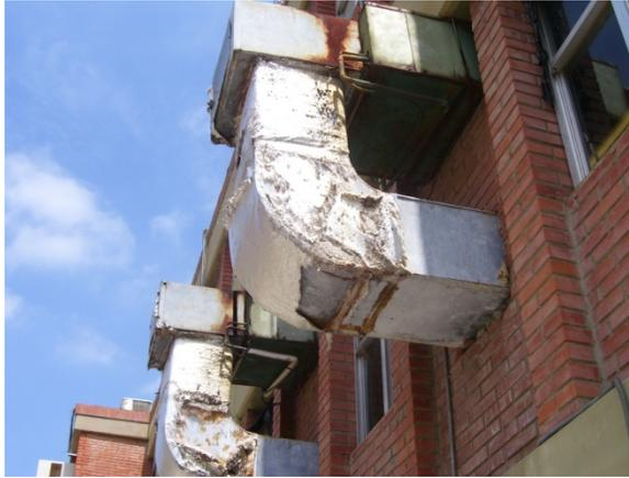
Figura C.11. Ductos de aires acondicionados en mal estado
