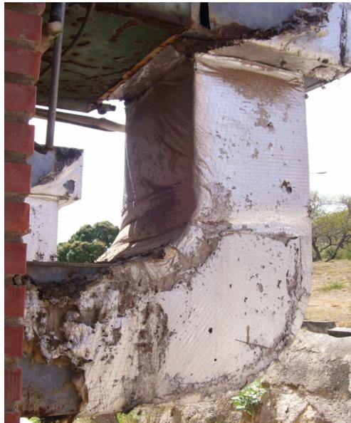
Figura C.10. Ductos de aire acondicionado en mal estado.
