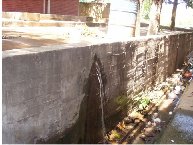
Figura C.13. Derrame de aguas blancas por las paredes.
