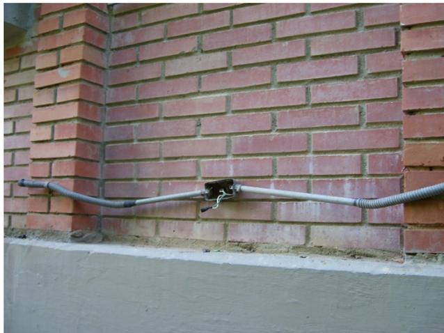
Figura C.33. Tomacorriente en mal estado. Pasillos.
