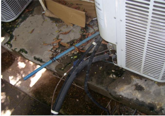
Figura C.39. Cables de corriente colocados en derrames de agua.
