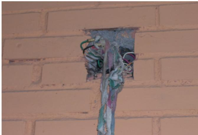
Figura C.28. Mal estado del cableado. Pasillos.
