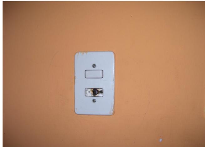
Figura C.36. Tomacorriente en mal estado. Aulas.
