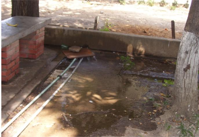
Figura C.7. Derrame de aguas blancas. Áreas de esparcimiento
