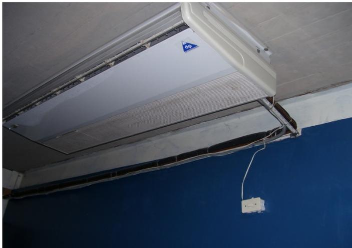
Figura C.18. Cableado no empotrado. Laboratorios.
