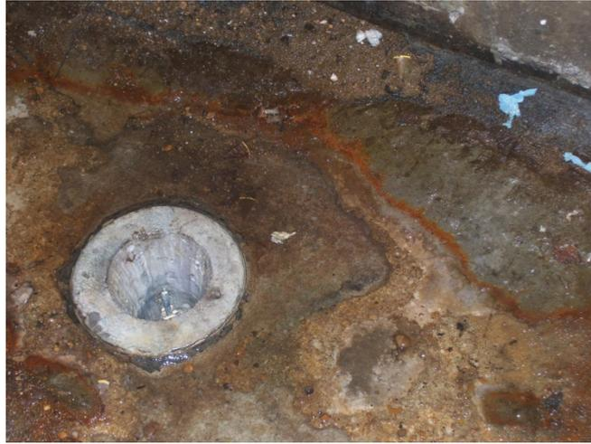
Figura C.16. Desagüe deteriorado. Laboratorios.
