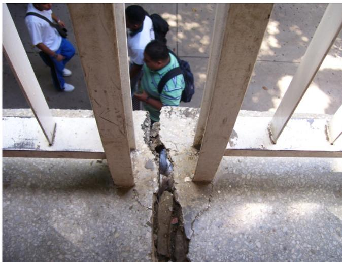
Figura C.38. Grietas en pisos. Pasillos segundo nivel.
