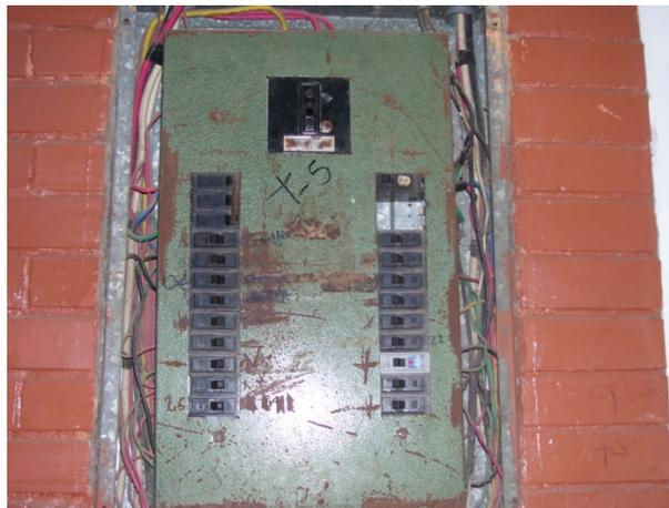
Figura C.12. Cajetín de alto voltaje no señalizado.
