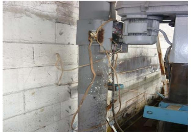
**Figura 5.4.** Conexiones expuestas
