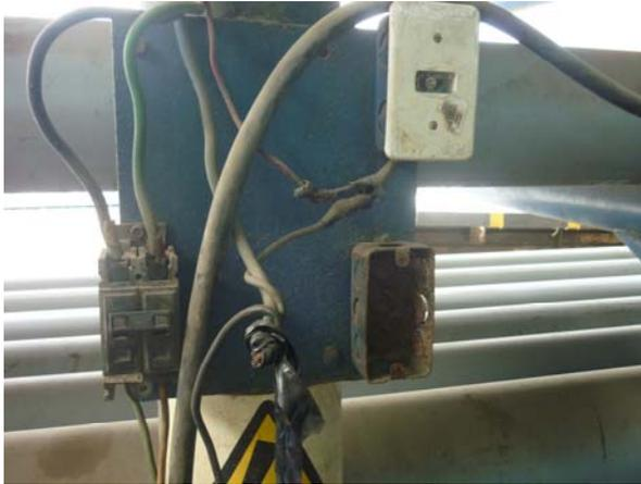
**Figura 5.3.** Cableado en mal estado eléctrico
