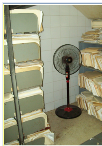
Figura 4.17. Ventilador. Único medio con el que se cuenta para generar ventilación en el archivo pasivo.
