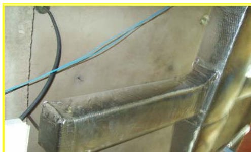
Figura 4.6. Techo de concreto.
