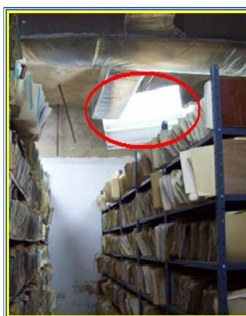
Figura 4.12. Lámparas parcialmente apagadas y a punto de caer en el archivo B.
