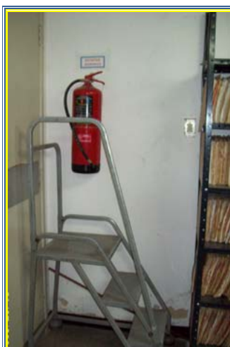
Figura 4.38. Extintor de incendios del archivo B el cual está atrapado detrás de la escalera
