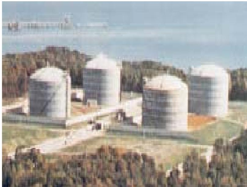
**Figura 3.6 Tanques de contención sencilla.**
