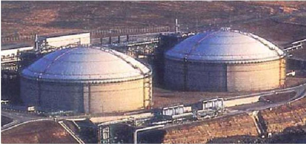
**Figura 3.9 Tanques de Contención Completa**
