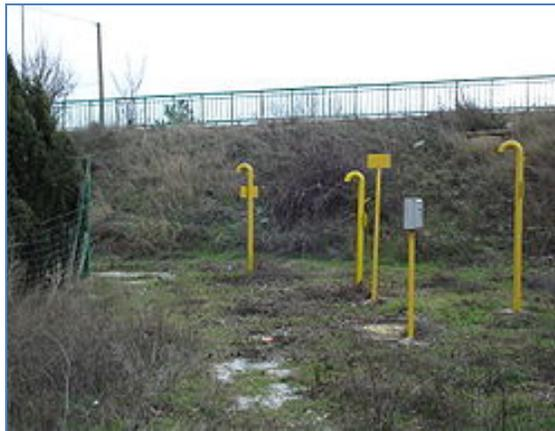
**Figura 3.15 Señales de un gasoducto cercano.**
