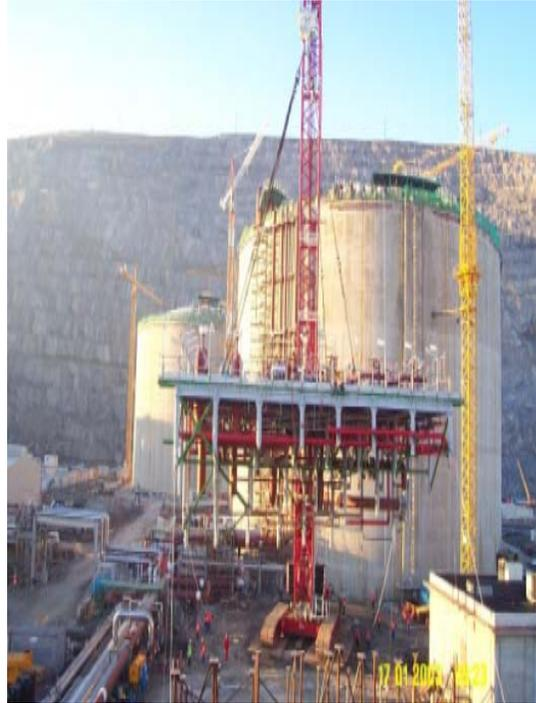
**Figura 3.7 Tanques de contención doble para el almacenamiento de GNL.**
