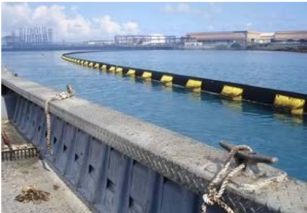
Figura 3.19 Barrera contención permanente [38].
