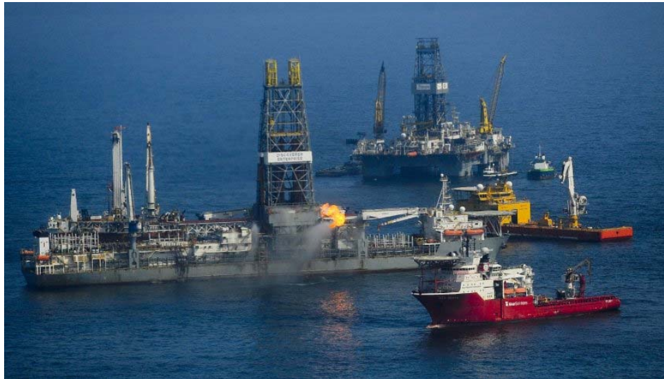
Figura 3.8 Llegada e instalación de las plataformas encargadas de perforar los pozos de alivio y recuperar crudo [28].
