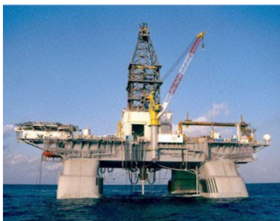
Figura 2.7 Plataforma Deepwater Horizon antes del accidente [18].
