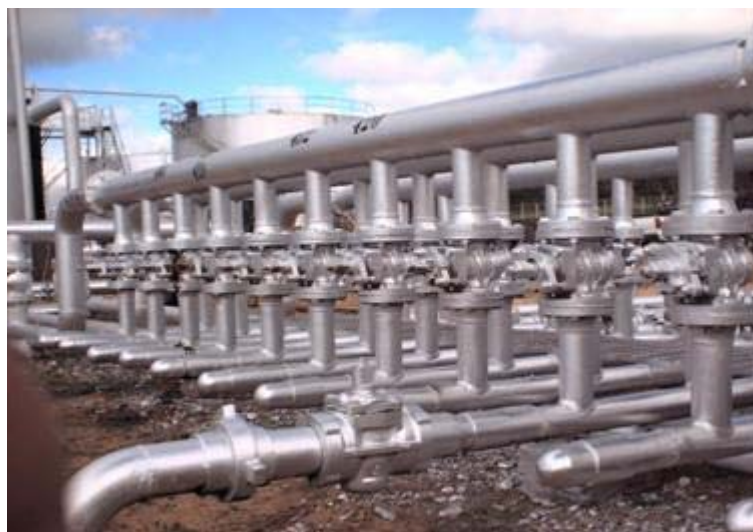
Figura 3.11 Múltiple de producción y prueba [31]
