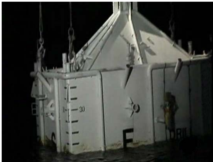
Figura 3.14 Operación de inmersión de la campana de taponamiento [33].
