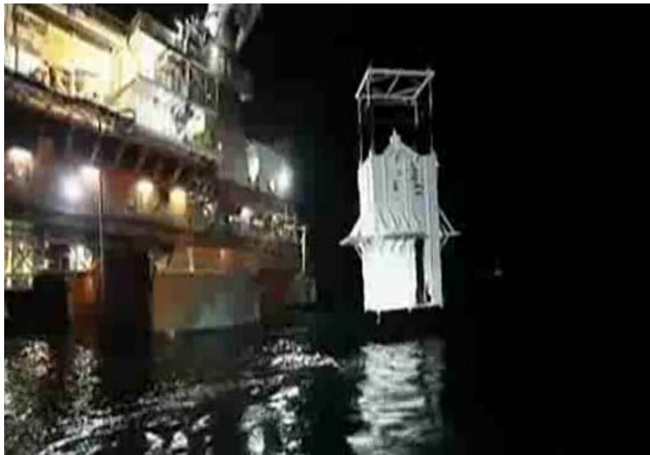
Figura 3.13 Campana blanca de 98 toneladas de hierro y hormigón utilizada por BP para taponar el pozo fuera de control y recuperar hidrocarburos [33].
