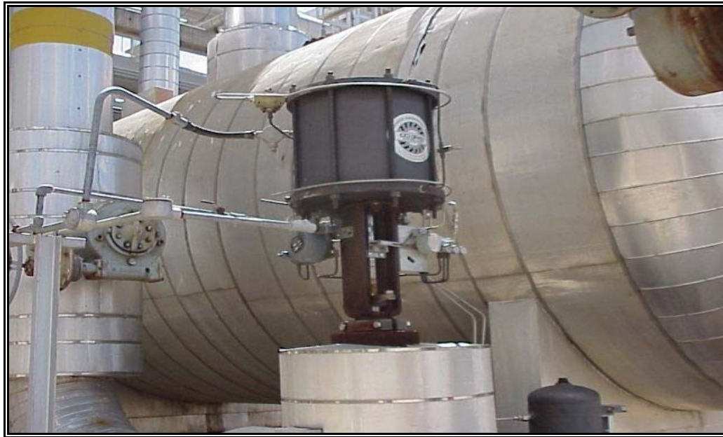
Figura 3.6 Válvula J-T de alta presión.
