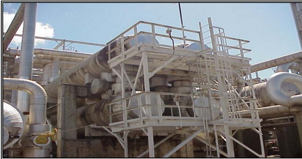
Figura 3.8 Intercambiador gas frío/gas de baja presión.
