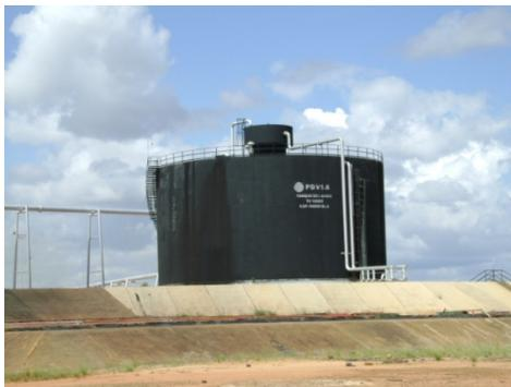
**Figura 2.10.** Tanque de Lavado de la estación de descarga BARED-10.
