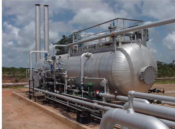
**Figura 2.11.** Deshidratador electrostático de la estación de descarga GUARA-10. PDVSA
