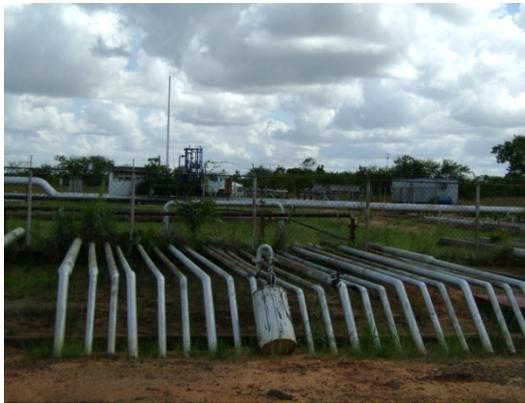
**Figura 2.7.** Múltiples de producción de la estación de descarga BARED-10.
