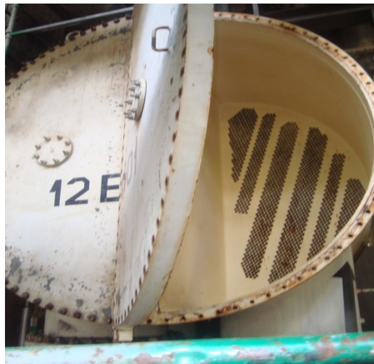
Figura 2.7. Condensador de superficie (12/22-E-401)
