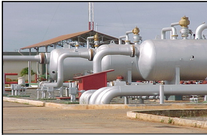
Figura 2.3. Separadores de producción.
