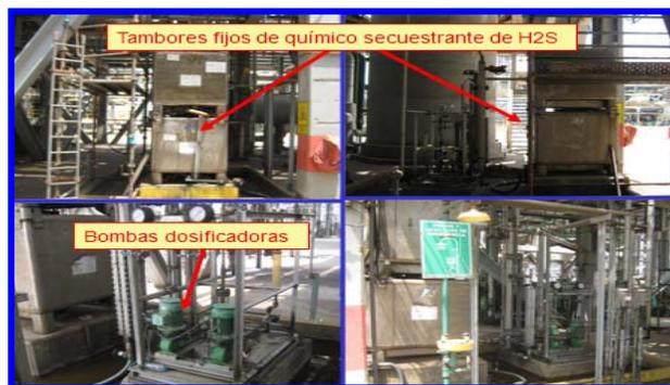
**Figura 4.9** Imagen de los equipos para la inyección de secuestrante de  $H_2S$  en la corriente de sincrudo (tambores y bombas dosificadoras).
