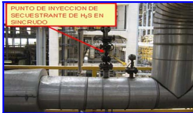
**Figura 3.7** Punto de inyección de secuestrante de H<sub>2</sub>S en la corriente de sincrudo, a la entrada del mezclador ubicado en MHC.
