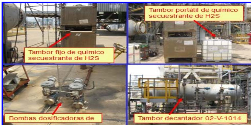
**Figura 4.5** Imagen del tambor decantador 02-V-1014 y los equipos para la inyección del químico secuestrante de H<sub>2</sub>S (tótem y bombas dosificadoras).
