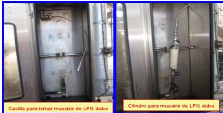
**Figura 3.6** Toma muestra de LPG dulce, con facilidad de conexión para el cilindro presurizado.
