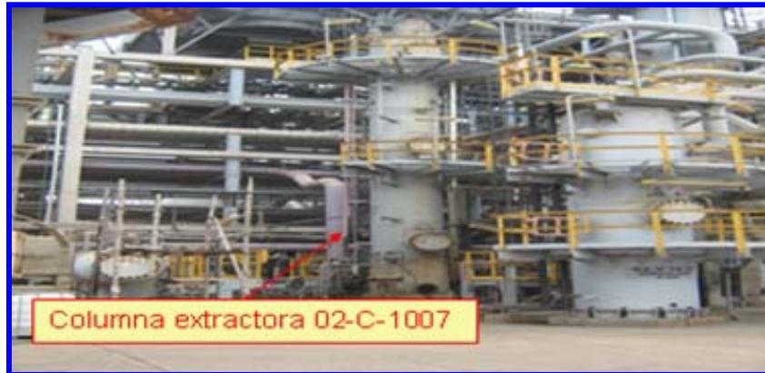
**Figura 4.1** Columna extractora con amina (MDEA) de la unidad de hidrotreatmento.
