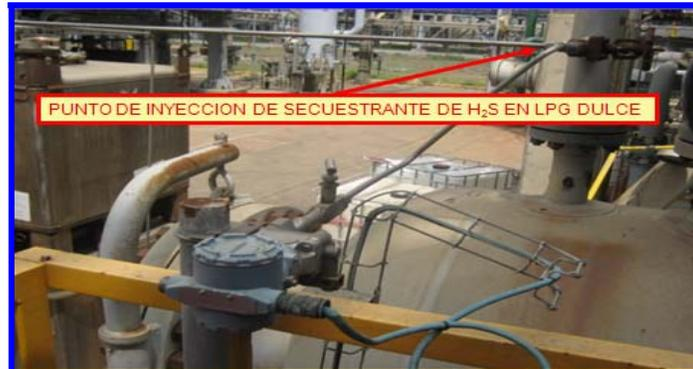
**Figura 3.5** Punto de inyección de secuestrante de  $H_2S$  en la corriente de LPG, a la salida del tambor 02-V-1014.
