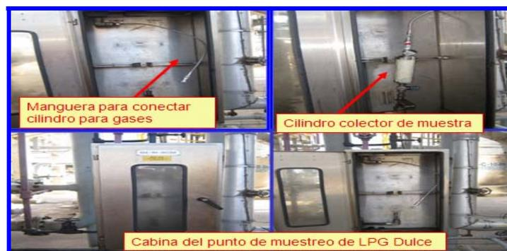
**Figura 4.7** Imagen del punto toma muestra de la corriente de LPG dulce.
