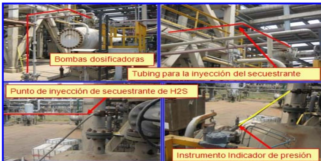
**Figura 4.6** Imagen del punto de inyección del secuestrante de H<sub>2</sub>S en la corriente de LPG dulce.
