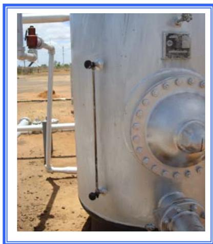
**Figura 4.1** Visor de nivel separador E-958 inservible
