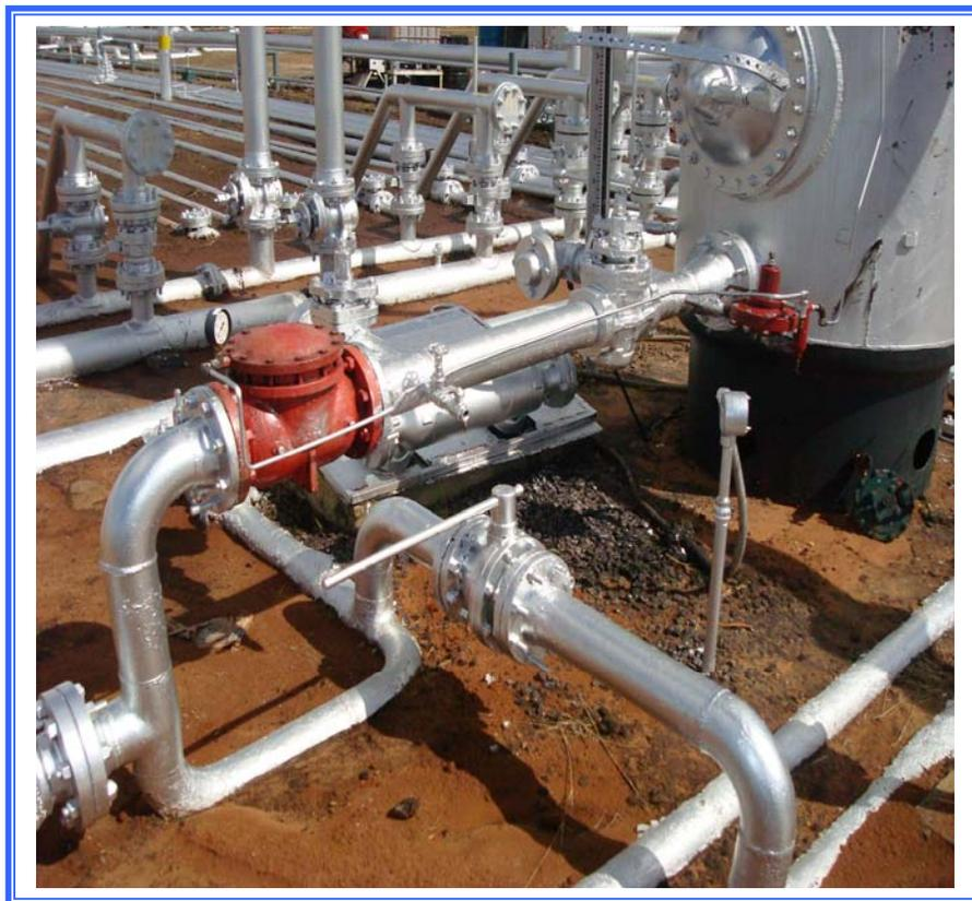
**Figura 4.3.** Separador E-12 equipado con una válvula de accionamiento mecánico de la estación de descarga Guara-14 (GED-14).
