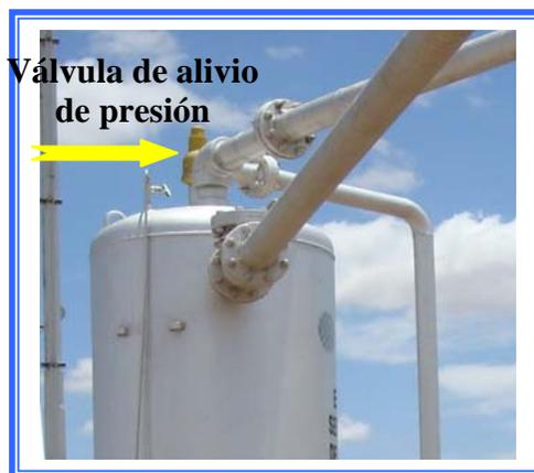
**Figura 3.3** Válvula de alivio de presión E-105 de la estación de descarga GUARA-14.
