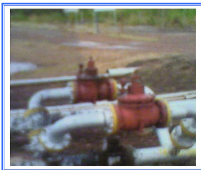
**Figura 3.4** Válvulas reguladoras de presión de la estación de descarga GUARA-14.
