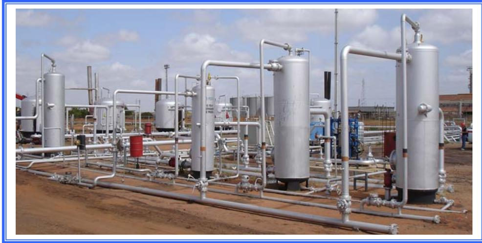
**Figura 2.5** Tren de separadores gas-petróleo. Estación de descarga Guara 14.
