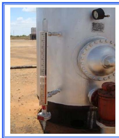
**Figura 4.2** Visor de nivel del separador E-105
