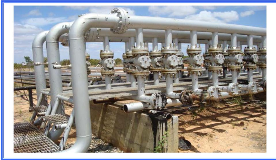
**Figura 2.3** Fotografía de un múltiple de producción, Guara, estación de flujo 15.
