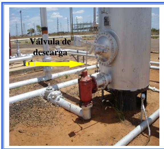
**Figura 3.2** Válvula de descarga del separador E-105 de la estación de descarga GUARA-14.
