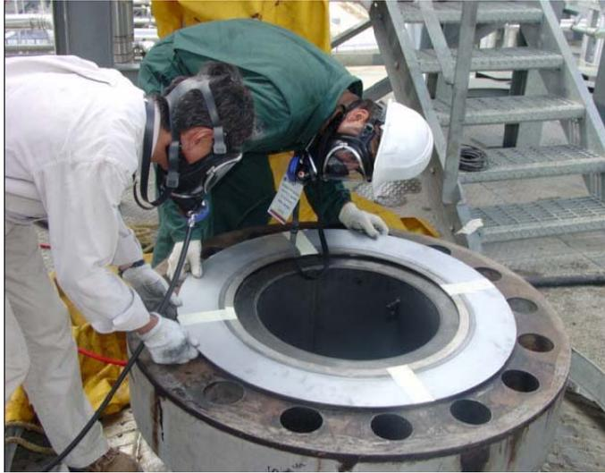
**Figura 1. Torqueado en caliente del intercambiador de calor E-4502
