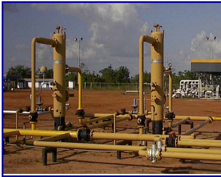
Figura 2.3 Separadores de tipo vertical. [12]
