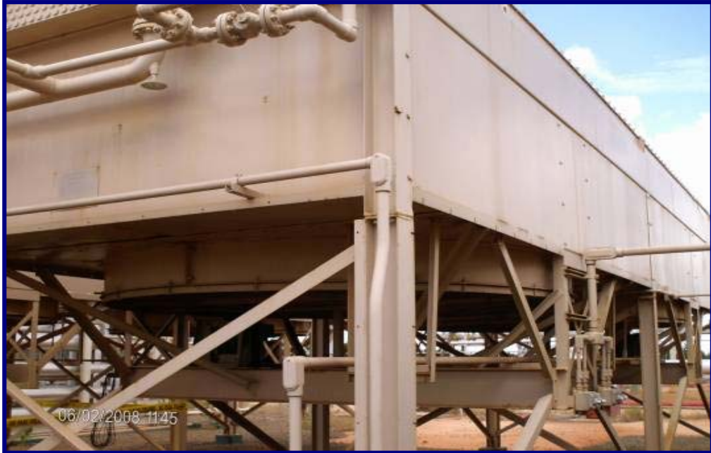
Figura 2.8 Enfriador por aire. [19]
