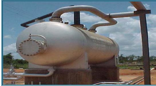
**Figura 2.8** Separador Horizontal por Gravedad.
