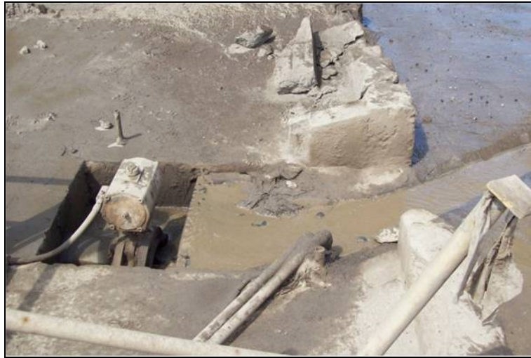
Figura 4.22 Entrada al desarenador de Equipo Pesado.
