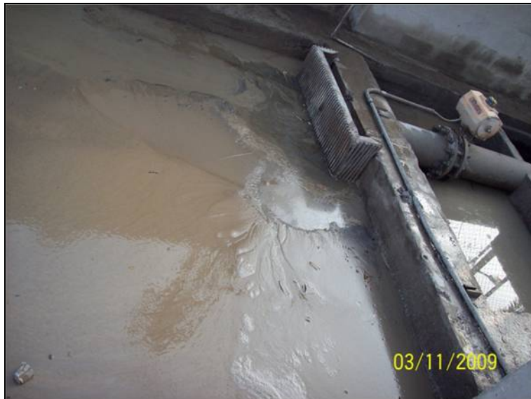
Figura 4.18 Entrada al desarenador de Equipo Liviano.
