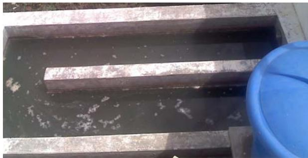
**Figura 4.5 Sólidos suspendidos en la cámara de cloración**
