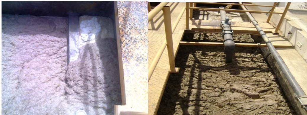
**Figura 4.14 Espumas presentes en el sedimentador secundario**
