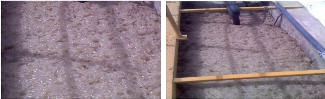
**Figura 4.13 Espumas presentes en el tanque de aireación**
