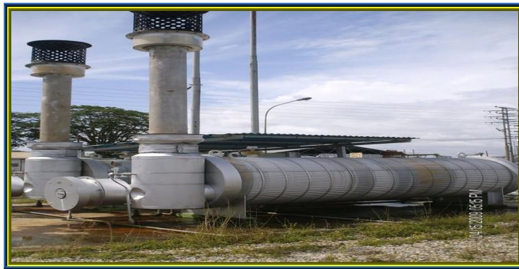
**Figura 2.3.** Calentadores del sistema gas combustibles.
