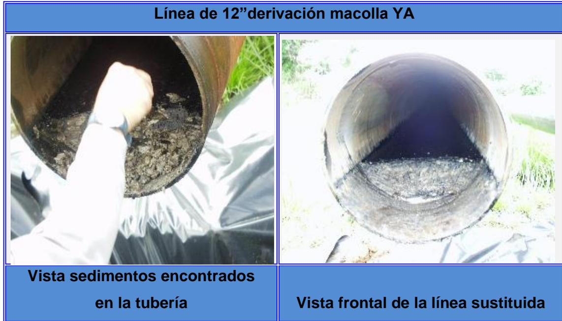
**Figura 4.12 Imágenes de línea de 12" sustituida en 2006 por obstrucción con arena. Fuente: Petrocedeño.**
