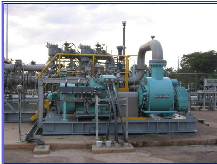
Figura 2.6. Arreglo de bomba multifásica en Petrocedeno.
