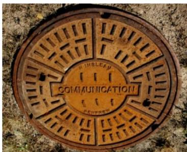
Figura 2.1. Corrosión uniforme, de una tapa de hierro.
