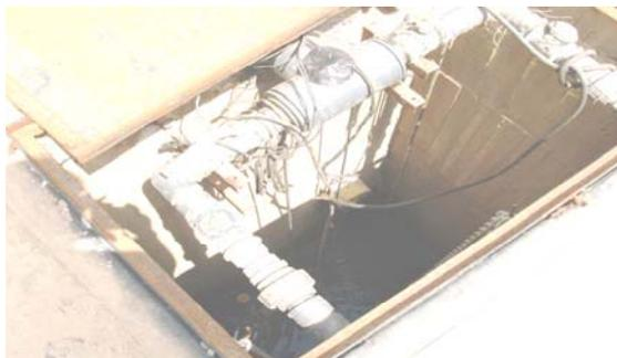
**Figura 2.2** Tanquilla de prebombeo. Planta de Tratamiento C.C. Sigo La Proveeduría.
