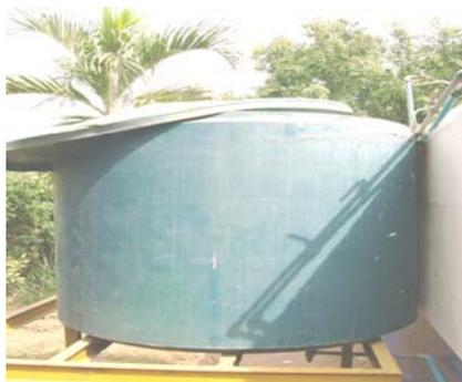
**Figura 2.10** Tanque de dosificador de la solución de  $\text{CaClO}_2$ . Planta de tratamiento Tapas Corona S.A.
