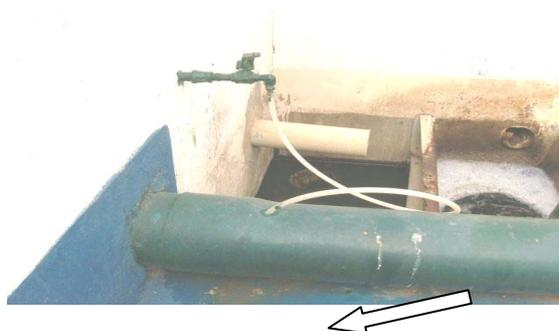
**Figura 2.11** Dosificación de la solución de  $\text{CaClO}_2$ . Planta de tratamiento Tapas Corona S.A.
