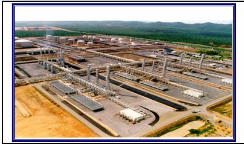
Figura 1.1: Vista de la Planta de Fraccionamiento y Despacho José (PDVSA Gas)
