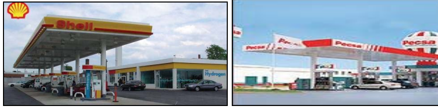
Figura 2.1. Estaciones de servicio de gas vehicular [5].
