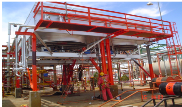
Figura 2.18. Enfriador por aire [15].
