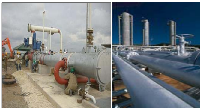
Figura 2.5. Instalación de gasoducto [5].
