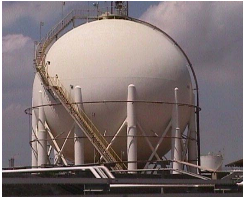
Figura 24. Esfera presurizada para almacenar pentano a 90°F y 2,5psi
