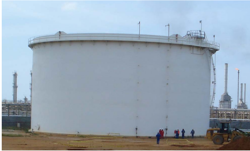
Figura 22. Tanque de techo flotante
