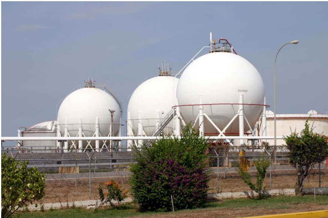
Figura 20. Esferas presurizadas para el almacenamiento de líquidos del gas natural
