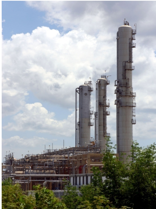
Figura 19. Torres de fraccionamiento de líquidos del gas natural
