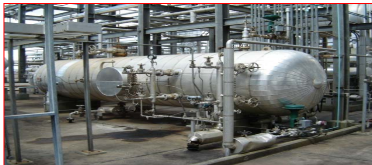
Figura 2.8. Tanque flash o tanque de venteo.
