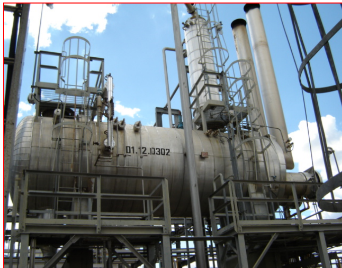
Figura 2.10. Rehervidor de Glicol.
