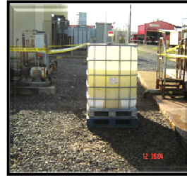
Figura 7. Exposición del NaOCl a la radiación ultravioleta del sol (Unidad 41).
