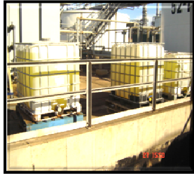
Figura 8. Exposición del NaOCl a la radiación ultravioleta del sol (Unidad 51).
