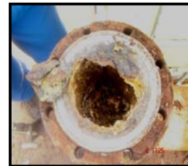
Figura 5. Sección interna de descarga hacia la tanquilla de Pequiven.
