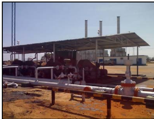
Figura 2.23 Estación de descarga
