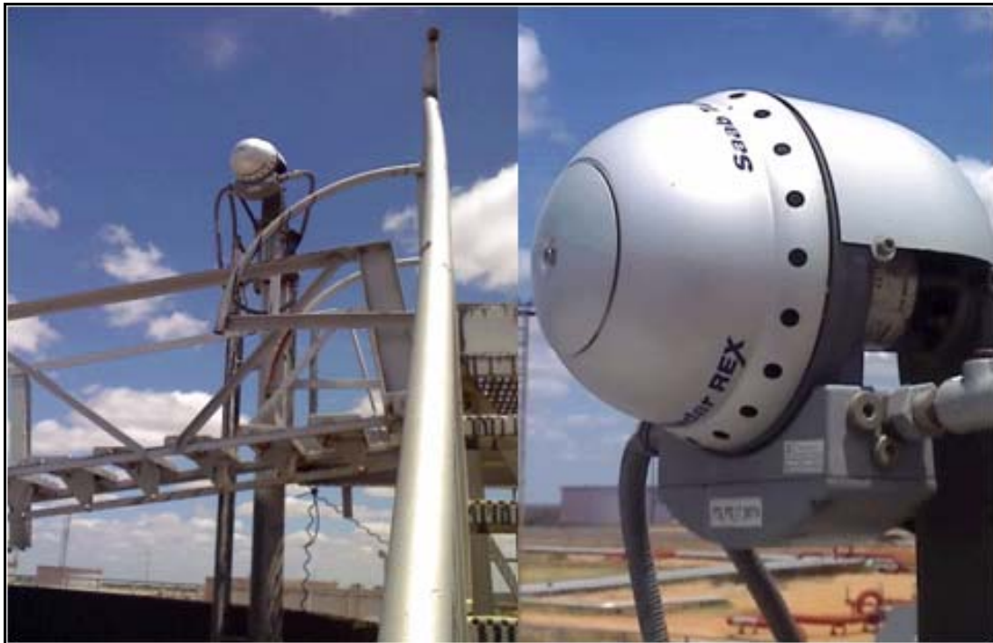
Figura 3.2 Sistema de medición en Radar del Patio Tanque Oficina (PTO)
