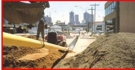
**Figura 2. 1 Tubería de Polietileno**
