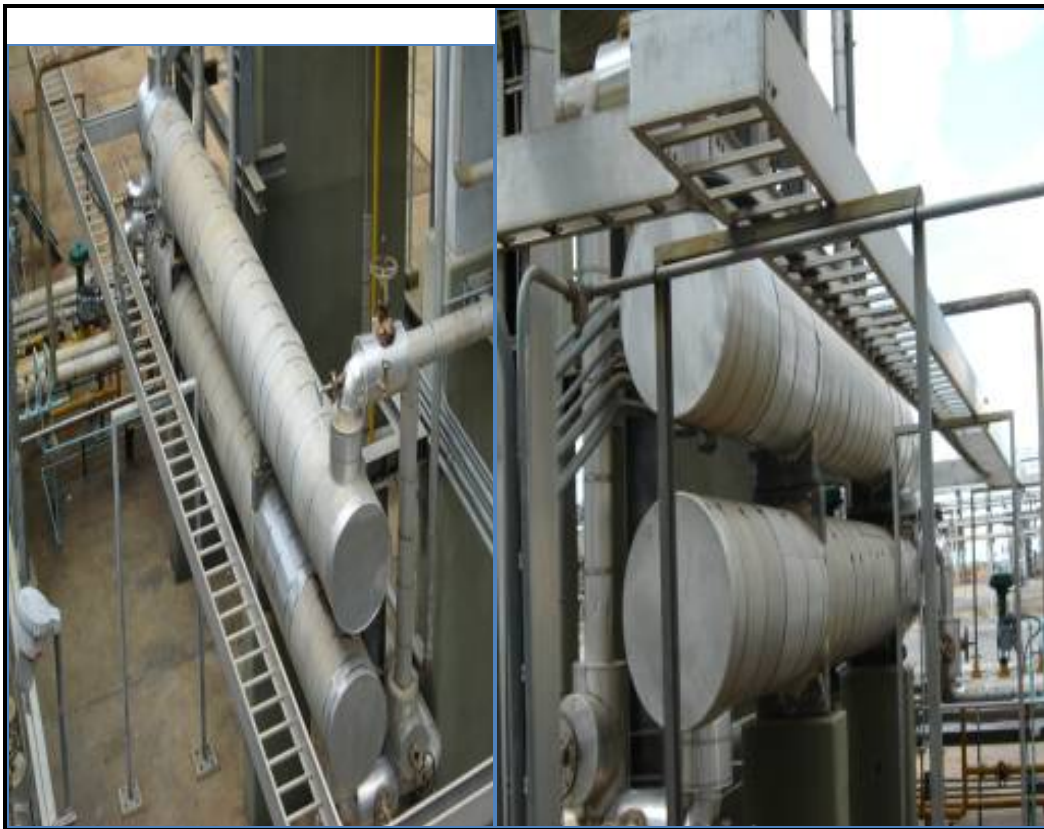
Figura 4.4. Intercambiadores laterales
