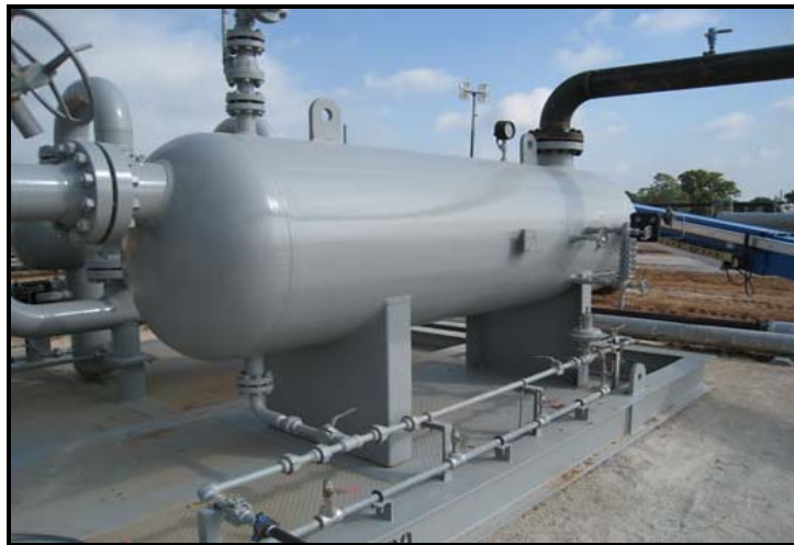
Figura 2.8. Separador horizontal
