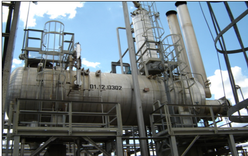
Figura 4.3 Rehervidor de Glicol
