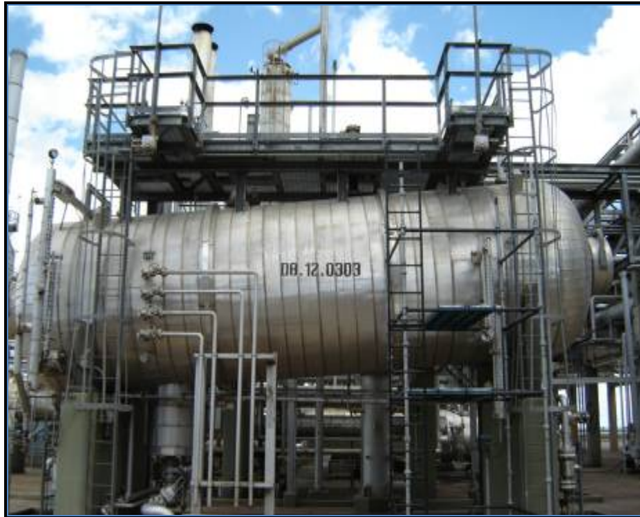
Figura 4.2. Desafaltenizador en el proceso de regeneración del glicol
