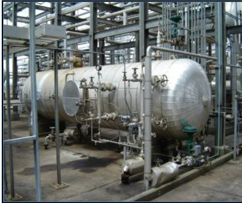
Figura 4.5. Flash tank de glicol
