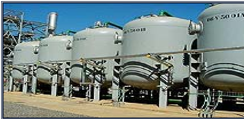
Figura 2.7 Filtros de carbón activado. (SINCOR,2001)
