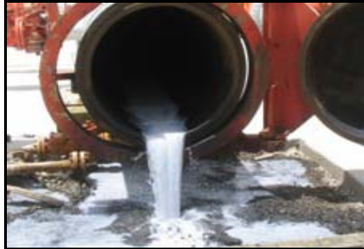
Figura 2.18 Condensación de líquidos en gasoductos.
