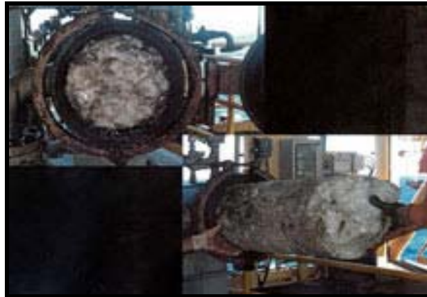
Figura 2.17 Formación de hidratos en gasoductos.
