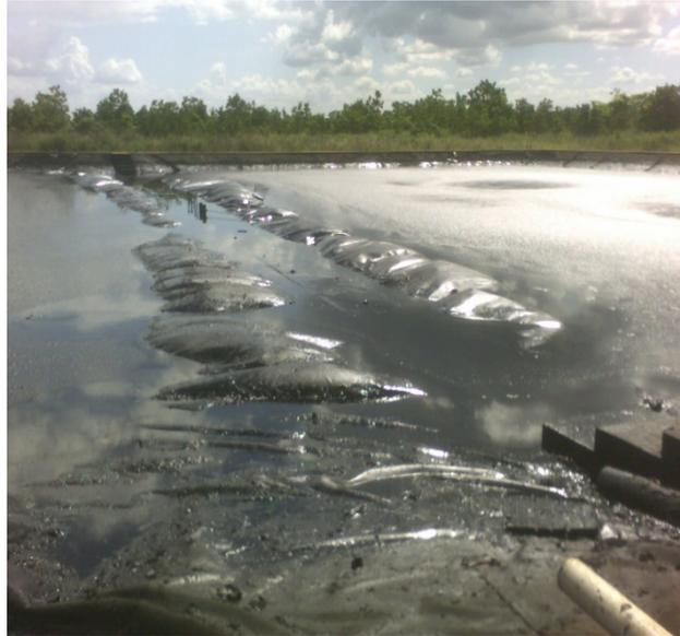
Figura 4.1 Barreras plásticas de contención de la fosa de PITASO.
