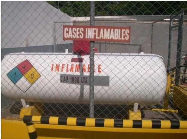
**Figura 1 y 2. Tanque de Gas Licuado de Petróleo (GLP)**
