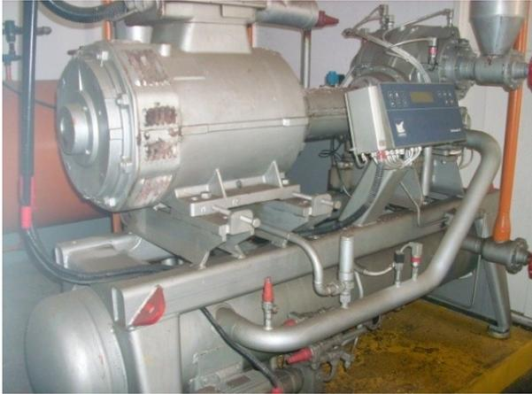
**Figura 5 y 6. Sistema de refrigeración por amoniaco**
