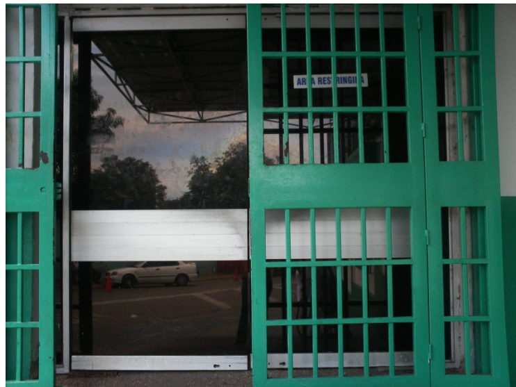
Puerta de Emergencia
