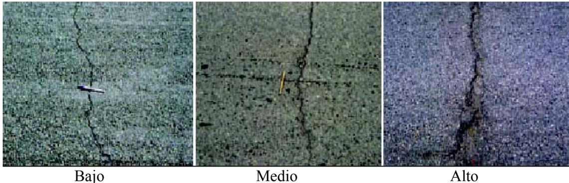
Figura 6. Grados de severidad del agrietamiento por fatiga térmica a bajas temperaturas (15).
