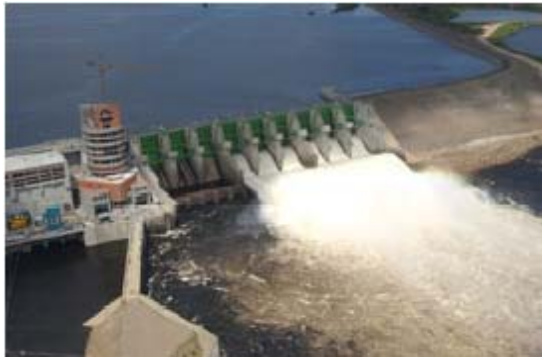
Figura 4. Central Hidroeléctrica de Caruachi
