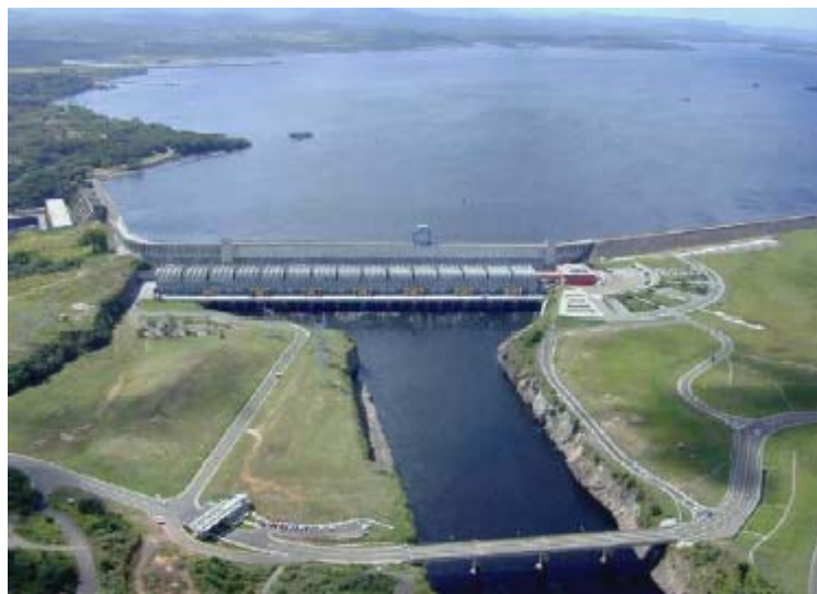
Figura 3. Central Hidroeléctrica Macagua II
