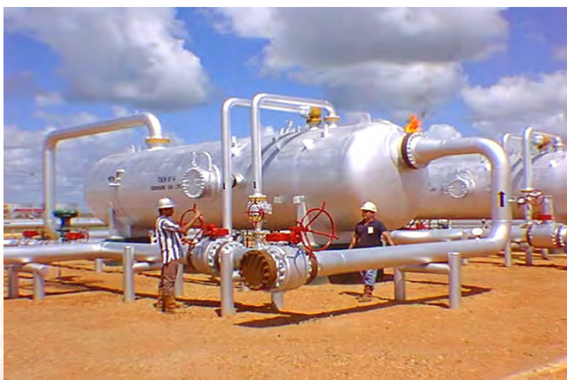
Figura 2.3 Separador Horizontal.
