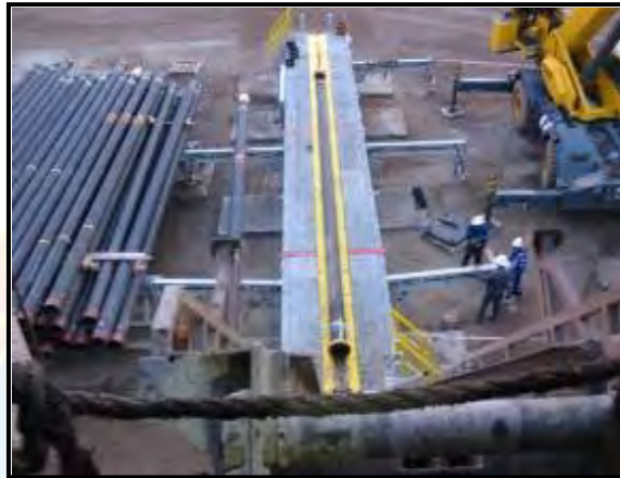
Figura 4.6 Subida del revestidor a la planchada Fuente: Nabors. (2012)
