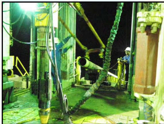
Figura 4.7 Ajuste del elevador al revestidor Fuente: Nabors. (2012)
