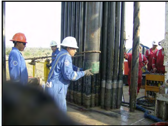
Figura 4.8 Guiar el revestidor al centro del pozo Fuente: Nabors. (2012)
