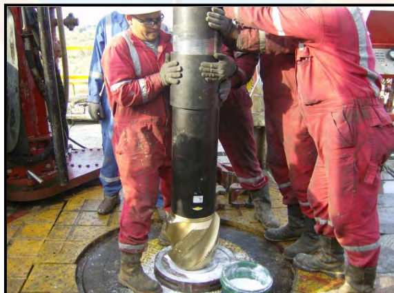
Figura 4.9 Instalación zapata del revestimiento Fuente: Nabors. (2012)
