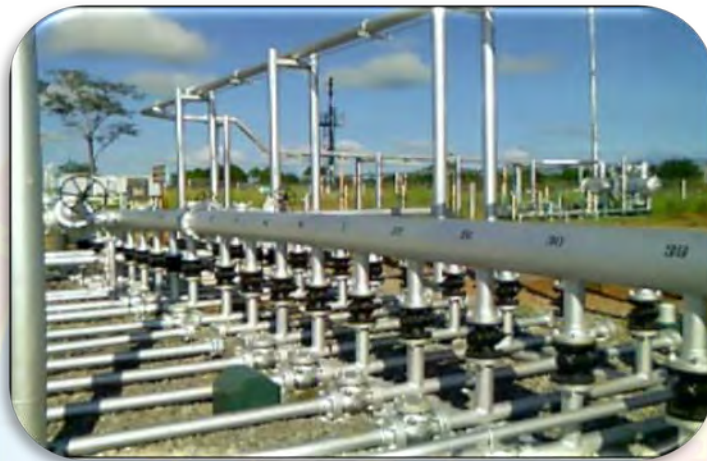
Figura 2.5 Múltiple de producción Fuente: Ingeniería de producción Orocual (2009)
