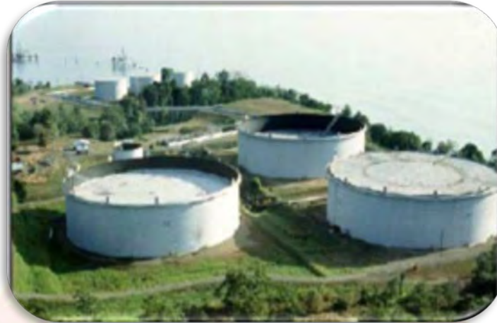
Figura 2.9 Tanques de almacenamiento Fuente: Ingeniería de producción Orocual
