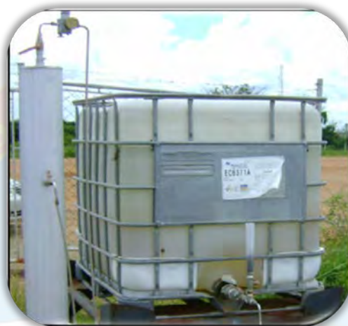
Figura 2.10 Tanque de almacenamiento de reductor de viscosidad Fuente: Ingeniería de producción Orocual, PDVSA
