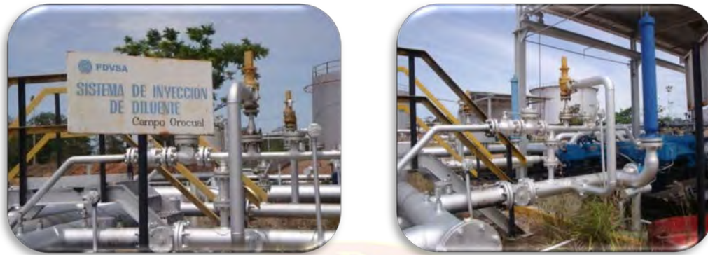
Figura 4.7 Sistema de inyección de diluyente de la EF-ORC-1 Fuente: Ingeniería de producción Orocuai, PDVSA (2009)
