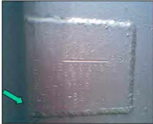
PLACA DE ESPECIFICACIONES DUTY=2.000.000 BTU/HR
