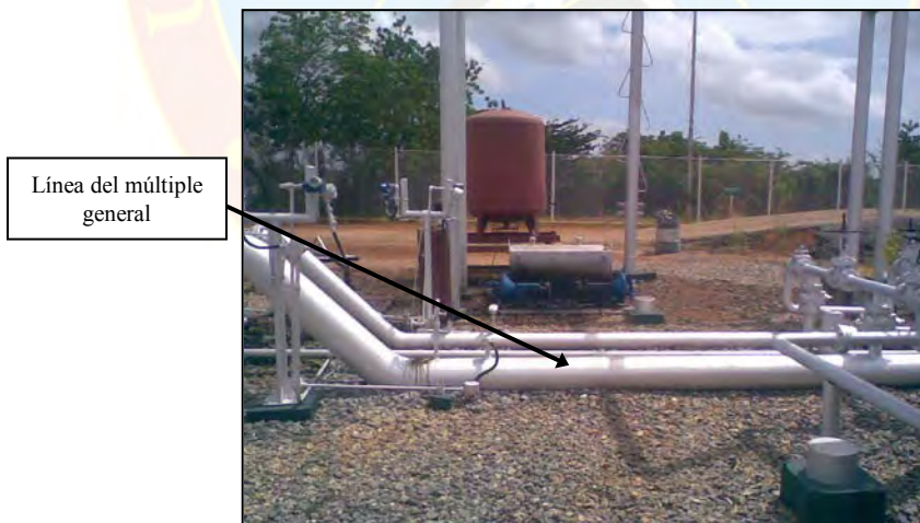
Figura B.2 Facilidad de línea 10 pulg (múltiple) para realizar la conexión al equipo calentador
