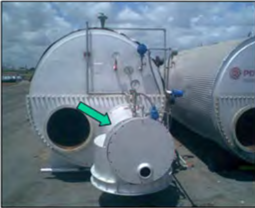
VISTA LADO QUEMADOR Y CHIMENEA
