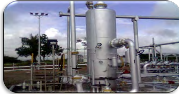
Figura 2.8 Depurador de gas Fuente: Ingeniería de producción Orocual
