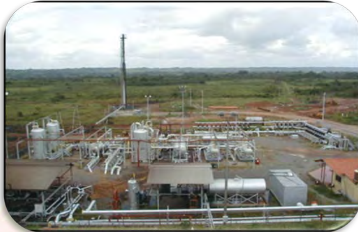
Figura 2.4 Estación de flujo Fuente Ingeniería de producción Orocual
