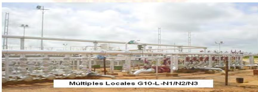
**Figura 2.3 Múltiple de producción general y de prueba**
