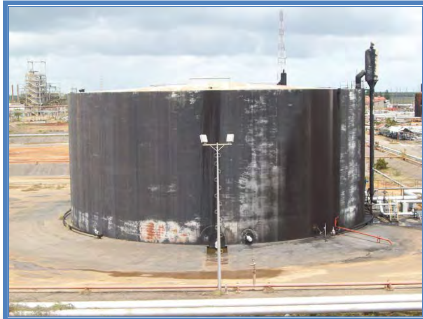
Figura C.5 Tanque de almacenamiento 80.003
