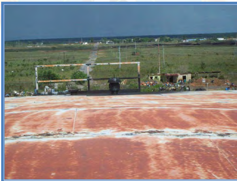
Figura C.14 Respirador tipo hongo del tanque de almacenamiento 80.004
