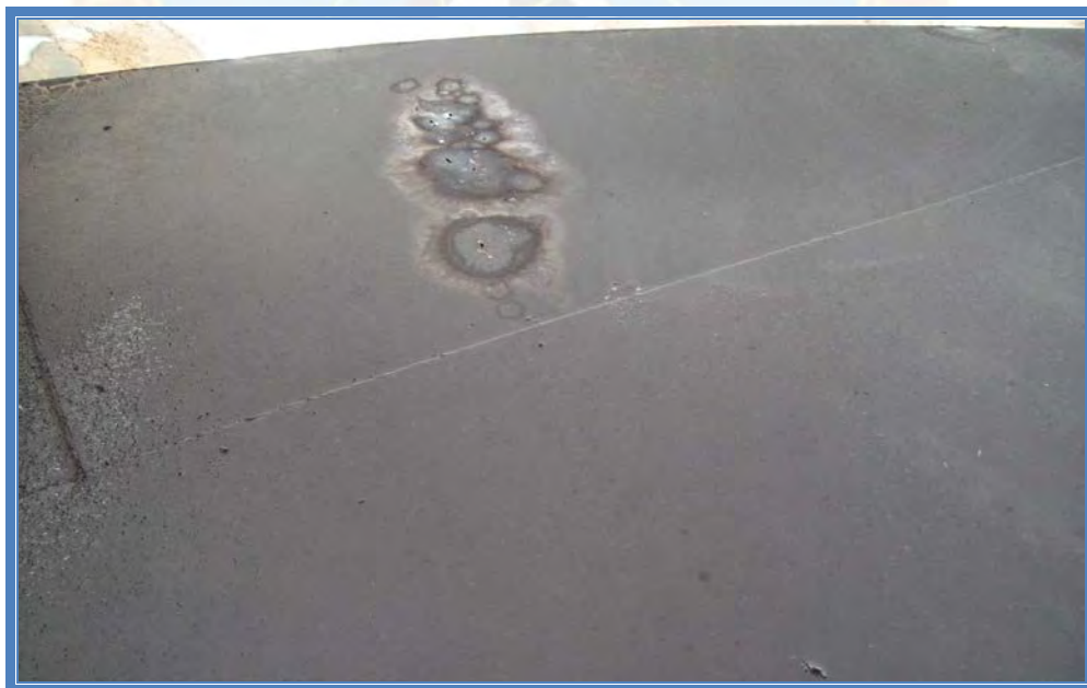
Figura C.12 Perforaciones en el techo del tanque de almacenamiento 80.003
