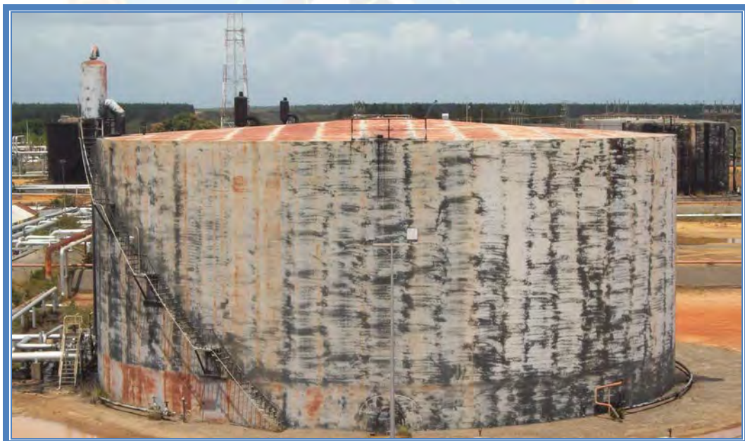
Figura C.6 Tanque de almacenamiento 80.004
