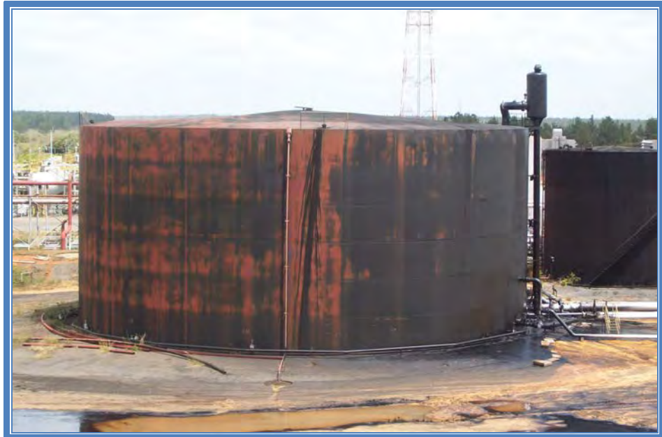
Figura C.3 Tanque de almacenamiento 80.001
