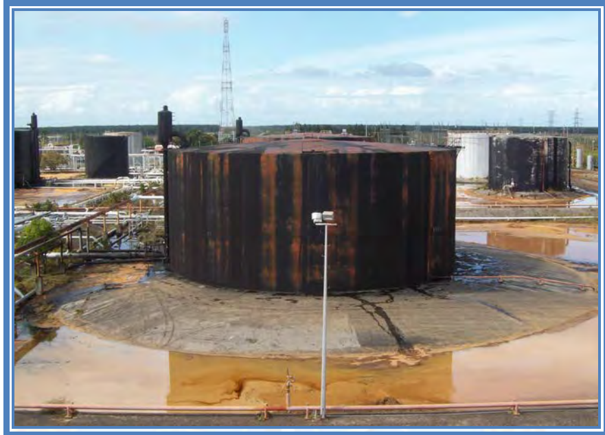
Figura C.1 Tanque de almacenamiento 55.001
