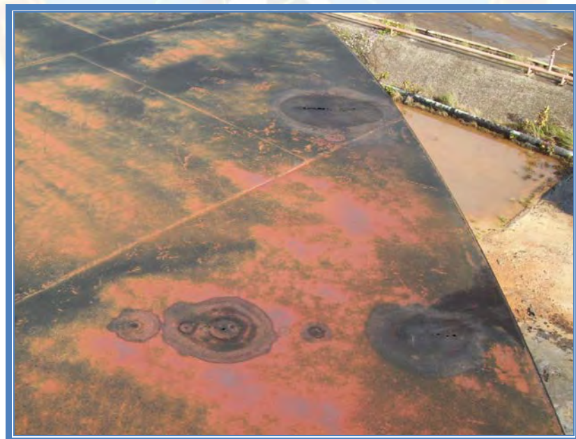
Figura C.8 Perforaciones en el techo del tanque de almacenamiento 55.001
