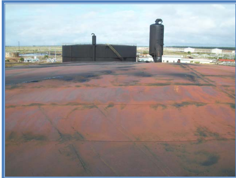
Figura C.7 Techo del tanque de almacenamiento 55.001
