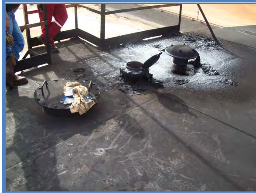
Figura C.11 Plataforma del aforador del tanque de almacenamiento 80.002
