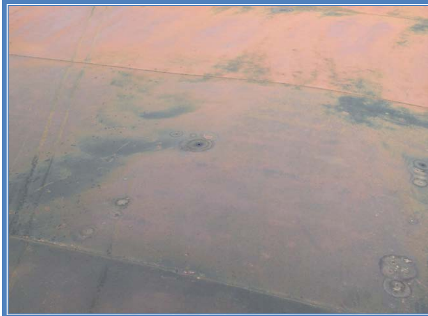
Figura C.9 Perforaciones en el techo del tanque de almacenamiento 55.001
