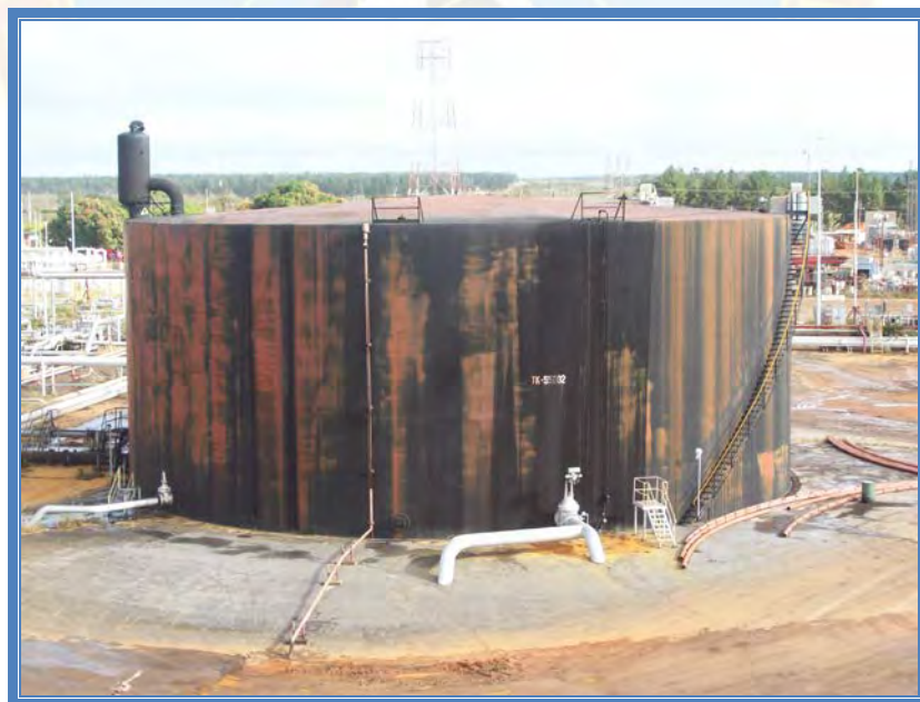
Figura C.2 Tanque de almacenamiento 55.002
