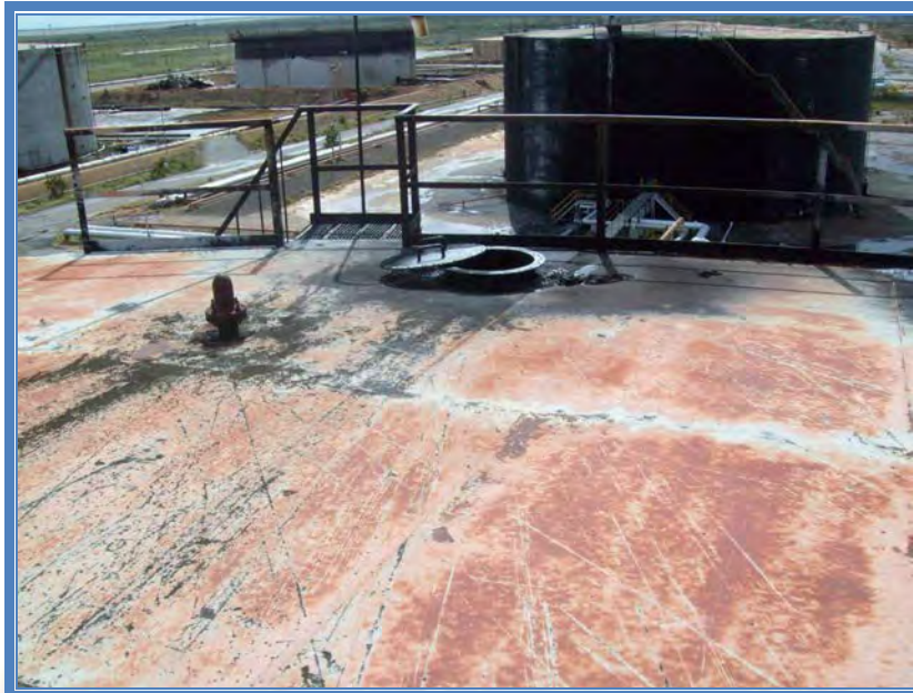
Figura C.13 Entrada hombre del tanque de almacenamiento 80.004
