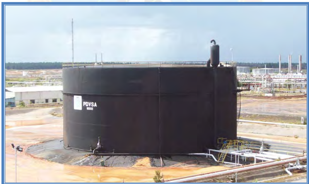
Figura C.4 Tanque de almacenamiento 80.002
