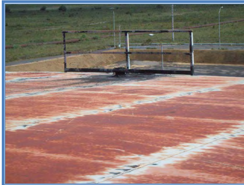
Figura C.15 Boca de aforo del tanque de almacenamiento 80.004
